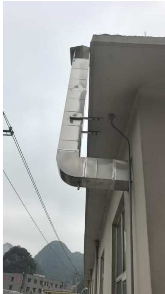
油烟净化装置及排气筒
