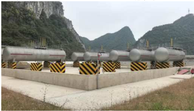
储罐区 1 米的围堰
