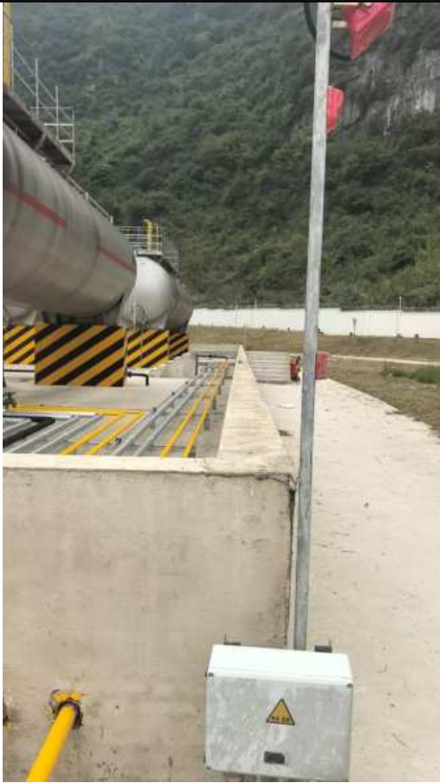
储罐区 1 米的围堰
