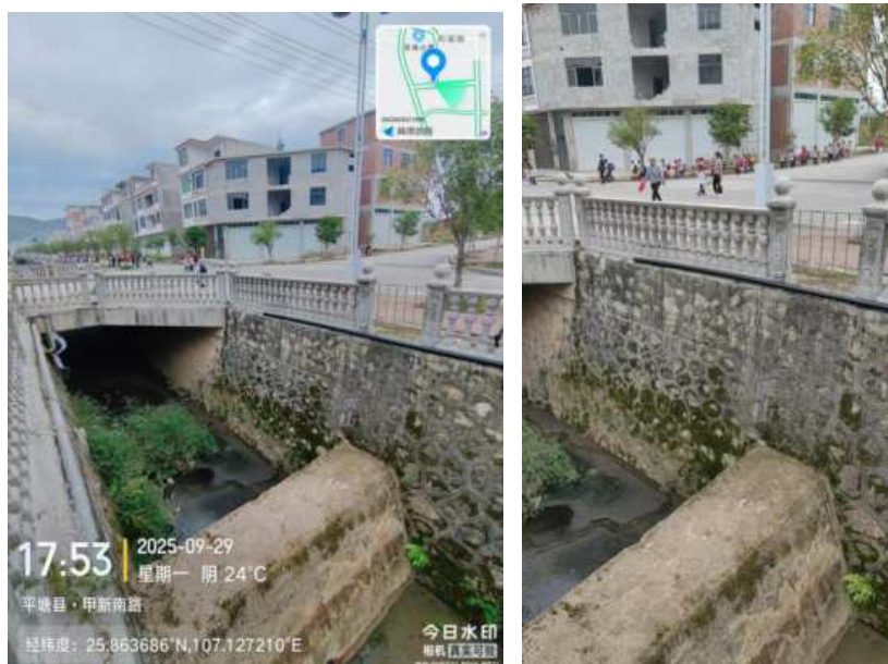
新建管道由出水渠接入镇区小溪
