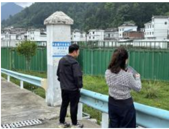
一体化处理设施
